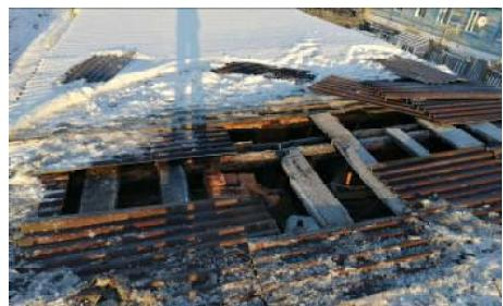
06.12.2020 в 20 часов 41 минуту на пункт связи 17 пожарно-спасательной части поступило сообщение о горении дома по адресу: г. Глазов, ул. Удмуртская. Пожаром повреждена обрешётка кровли. Причиной пожара послужила несоответствие размеров отступов от домовой трубы до конструкции здания.
