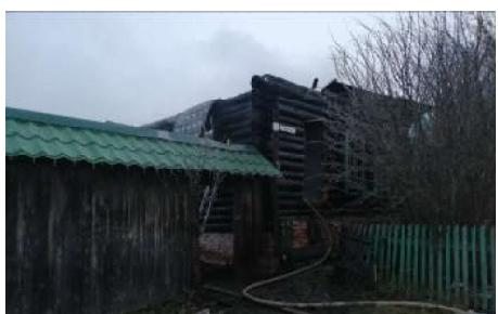
дом, надворные постройки. Повреждена обшивка соседнего дома. Причиной пожара является аварийный режим работы электросети, расположенной внутри надворных построек, с последующим воспламенением горючих материалов, деревянных конструкций строения.
